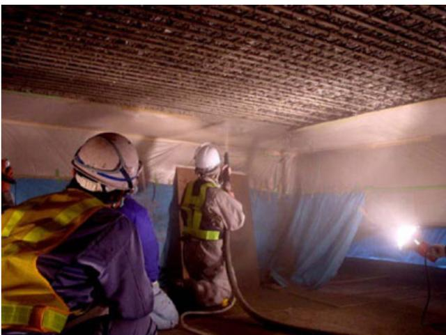
床版補修工 (粉塵抑制状況)
